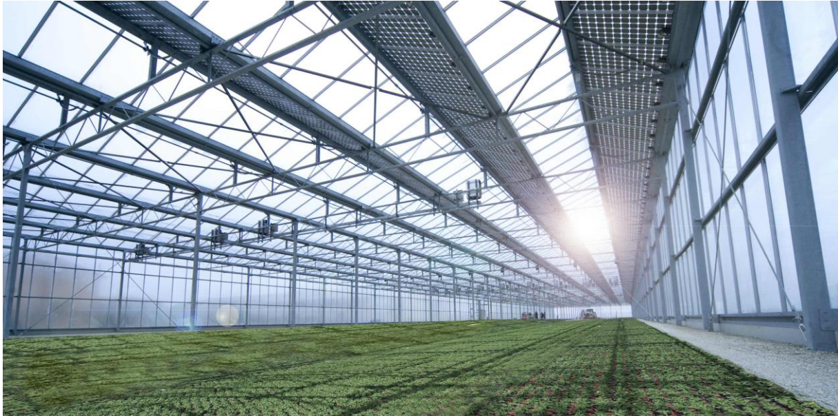
Perspective intérieure d'une serre maraîchère à toiture photovoltaïque
