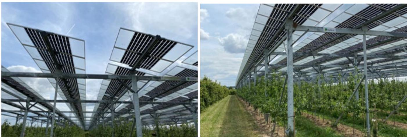
Figure 46 : rendus visuels de la technologie AgriPV de BayWa r.e. au niveau des pommiers sur le site de Gelsdorf (source : BayWa r.e.)
