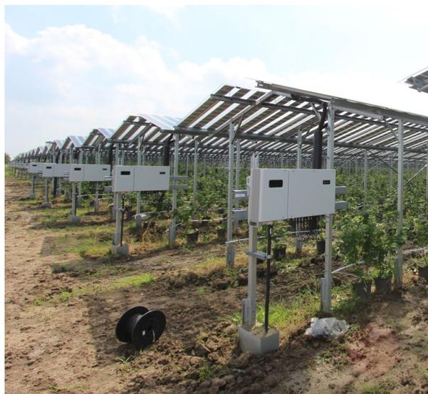
Figure 33 : Exemple d'onduleurs installés en bout de rangées du site Agri-PV sur groseilles de Wadenrijen, Pays-Bas (source : BayWa r.e.)
