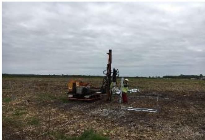
Figure 22 : battage des pieux sur une centrale photovoltaïque BayWa r.e. (source : BayWa r.e.)
