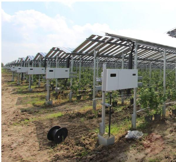
Figure 23 : Exemple d'onduleurs installés en bout de rangées du site Agri-PV sur groseilles de Wadenoijen, Pays-Bas (source : BayWa r.e.)
