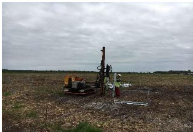
Figure 12 : battage des pieux sur une centrale photovoltaïque BayWa r.e. (source : BayWa r.e.)
