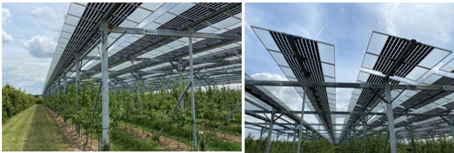
Figure 13 : rendus visuels de la technologie AgriPV de BayWa r.e. au niveau des pommiers à Gelsdorf en Allemagne (source : BayWa r.e.)
