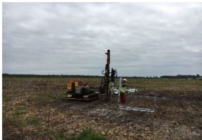
Figure 9 : battage des pieux sur une centrale photovoltaïque BayWa r.e. (source : BayWa r.e.)
