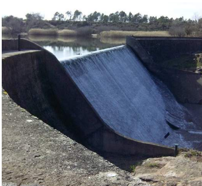
Barrage en situation de débordement
