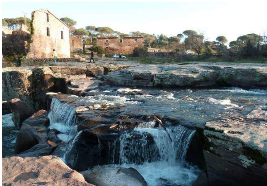
Ancienne scierie – Commune de Vidauban
