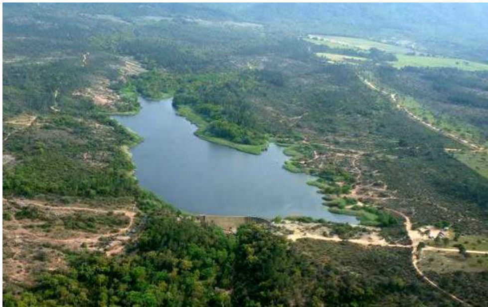
Vue aérienne du Lac des Escarquets et de son barrage (au premier plan)
