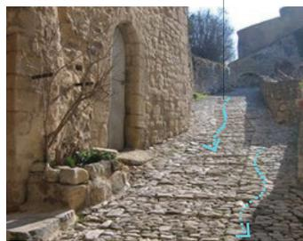
Figure 34 : Sols perméables des calades, pose sans joint des pierres
