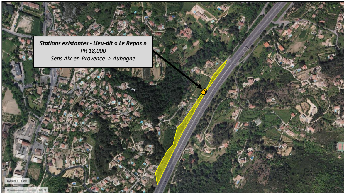
Vue aérienne du talus concerné par la demande de dérogation C1 (Les limites du talus sont matérialisés sur site par l'autoroute A52 et la clôture autoroutière) (Fond de plan : www.geoportail.fr )
