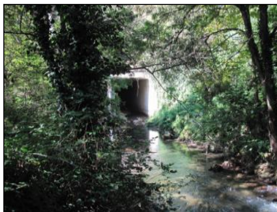
Vue de l'Huveaune au niveau du pont de l'autoroute A52
