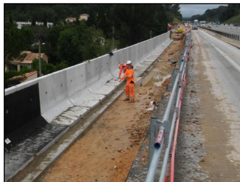
Travaux à réaliser dans la zone (de gauche à droite : Terrassement du remblai autoroutier existant ; Mise en œuvre du remblai d'assise du mur ; Pose du mur de soutènement) (Source : SETEC International)
