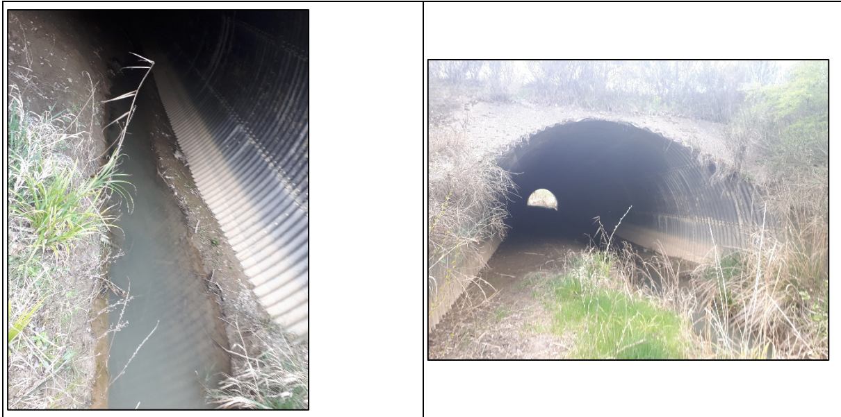
Aperçu de la buse autoroutière sur le Ravin de la Bête
