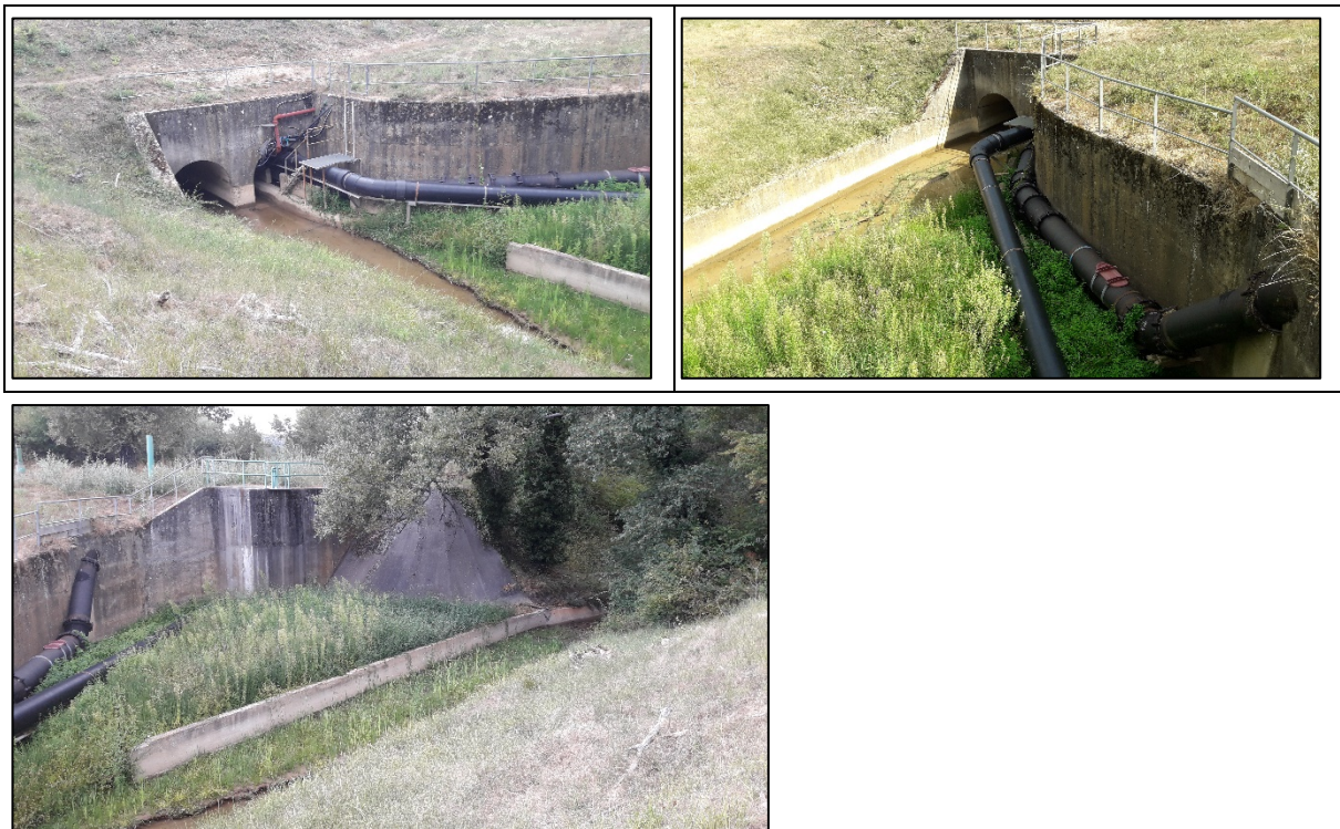
Aperçu de l'extrémité aval l'ouvrage hydraulique assurant le Ravin de la Bête sous le canal EDF
