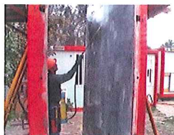
Utilisation systématique d'huile de décoffrage végétale
