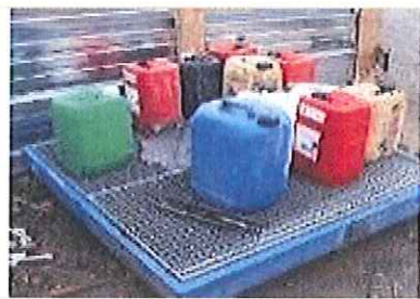
Stockage des produits dangereux sur bac de rétention
