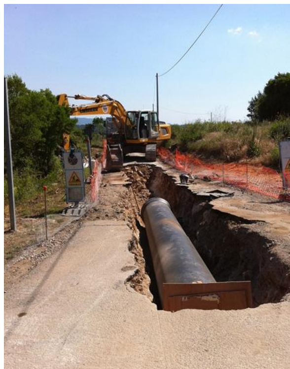
Travaux à l'avancement
