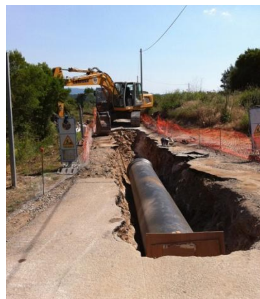
Travaux à l'avancement
