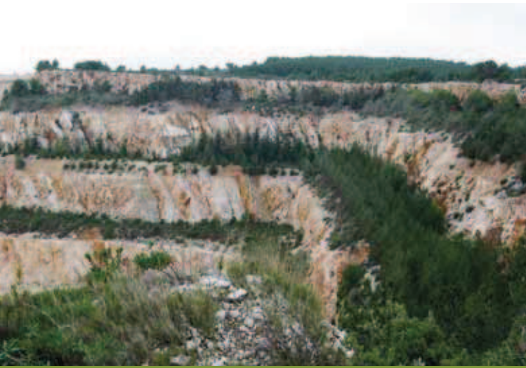
Réaménagement d'une carrière par végétalisation des anciens fronts de taille (© OR/DREAL PACA)
