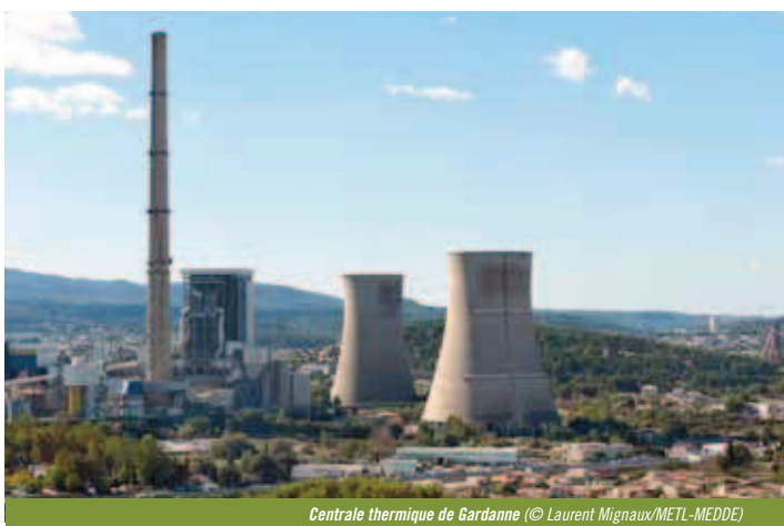
Centrale thermique de Gardanne (© Laurent Mignaux/METL-MEDDE)
