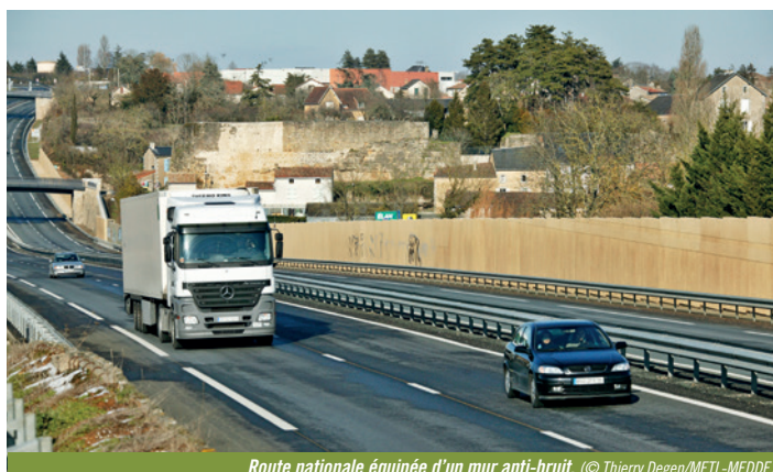
Route nationale équipée d'un mur anti-bruit. (© Thierry Degen/METL-MEDDE)
