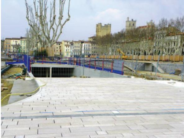
Exemple de trémie d'accès à un parking souterrain
