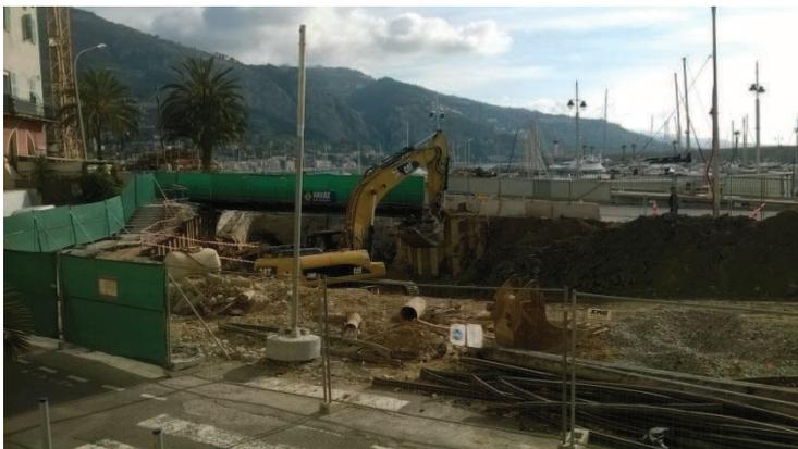
Travaux de terrassement en cours pour construire la trémie qui permettra aux véhicules d'entrer et sortir en passage inférieur, sous le quai Monléon
