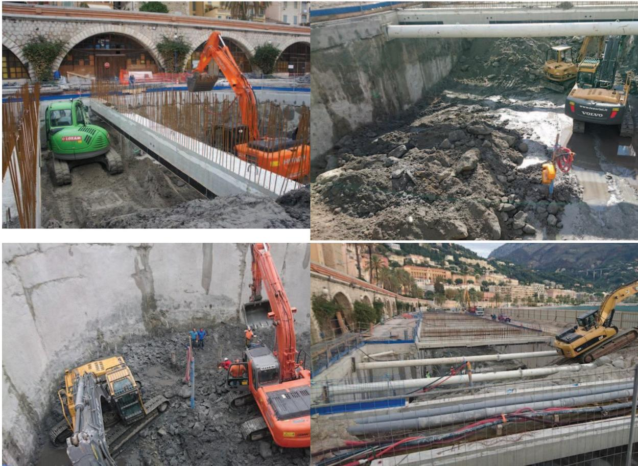
Des buttons<sup>8</sup> sont grésés provisoirement entre les deux parois moulées pour équilibrer les pressions hydrostatiques. Les eaux d'exhaure de la nappe sont pompées à l'extérieur, prétraitées et rejetées dans le bassin portuaire du Vieux-Port.
