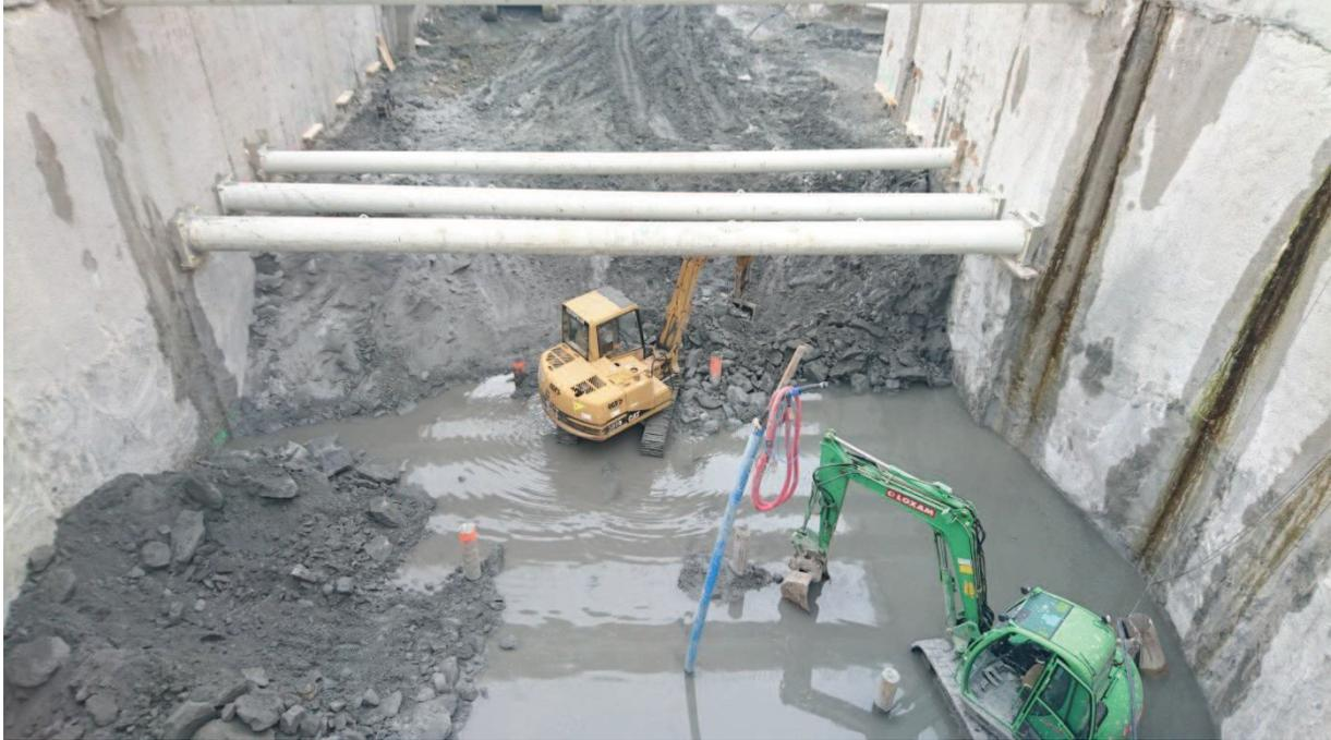
Le substratum compact marno-gréseux a nécessité l'emploi de moyens lourds de déroctage : les grès indurés sont fragmentés à l'aide de deux brise-roches hydrauliques (en haut de la photo) puis repris par les pelles mécaniques pour être évacués à l'extérieur (en bas de la photo).
