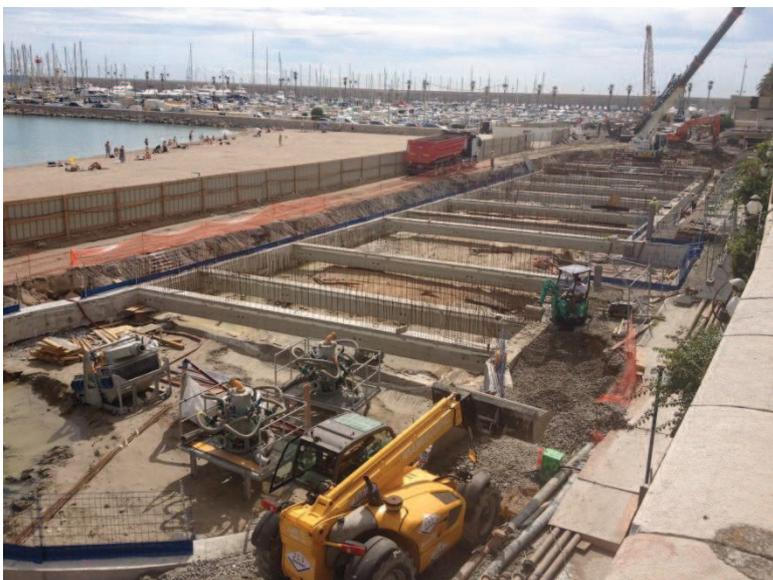
Les poutres de soutènement de la dalle supérieure du parking sont construites avant de commencer les terrassements.
