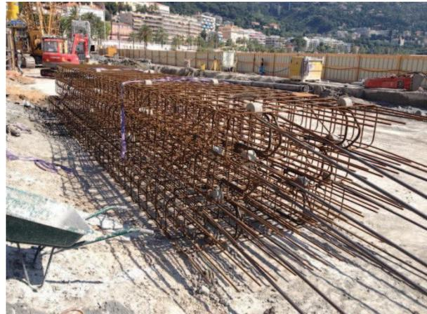
Des cages d'armature préfabriquées sont alors immergées dans la tranchée (à gauche) et cette dernière est ensuite bétonnée à l'aide d'un ou plusieurs tubes plongeurs (à droite, haut et bas).
