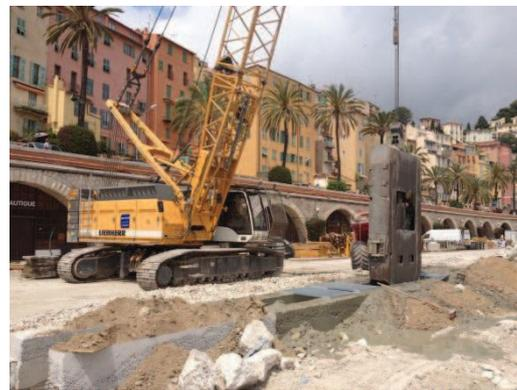
Lors de la réalisation d'une paroi moulée, on creuse, à l'aide de grappins rectangulaires spéciaux des tranchées individuelles dans le sol (« panneaux »), jusqu'à la profondeur requise.
