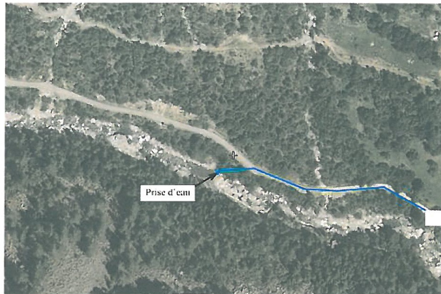
Vue aerienne de la zone d'implantation de la prise d'eau
