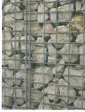
MUR EN SOUTÈNEMENT EN PIERRE
