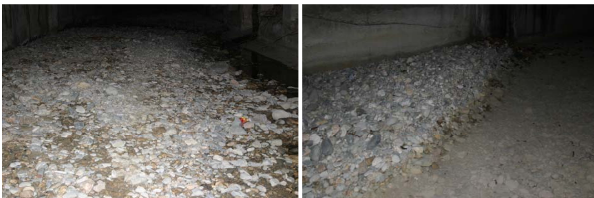
Figure 2: Photographies de la partie couverte du Borrigo.
