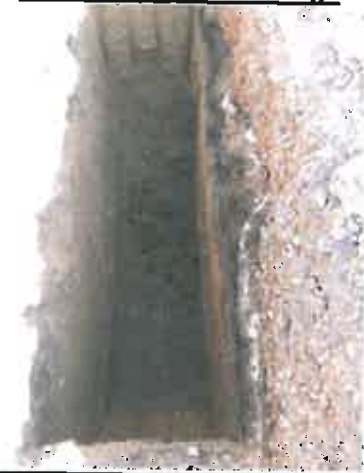
photographie du sondage
