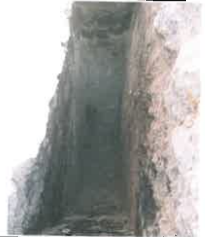
photographie du sondage
