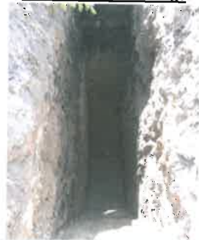
photographie du sondage
