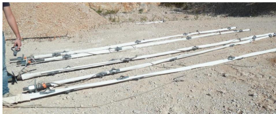
**Figure 35 : Barres d'ancrage équipées de géotextile (Photo : Naturalia)**
