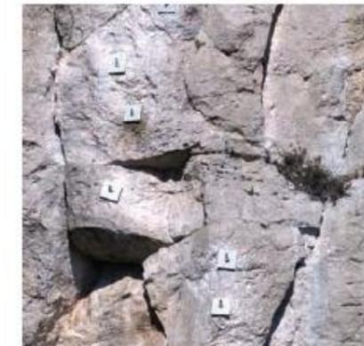
Exemple de confortement de points en falaise par ancrage
