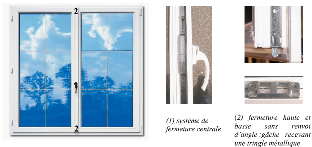
Figure 26 : système de fermeture classique à crémonne 3 points avec sortie de tringle (sans renvoi d'angle) d'une fenêtre à ouverture à la française
