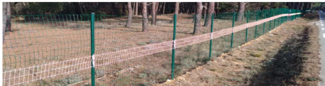
Clôture délimitant le périmètre de captage
