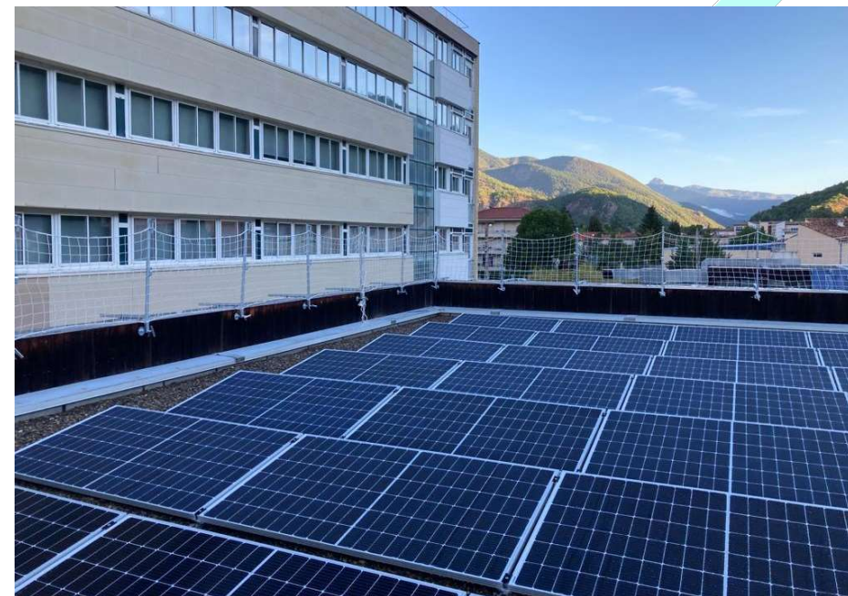
Lycée Alexandra David Neel à Digne-les-Bains
