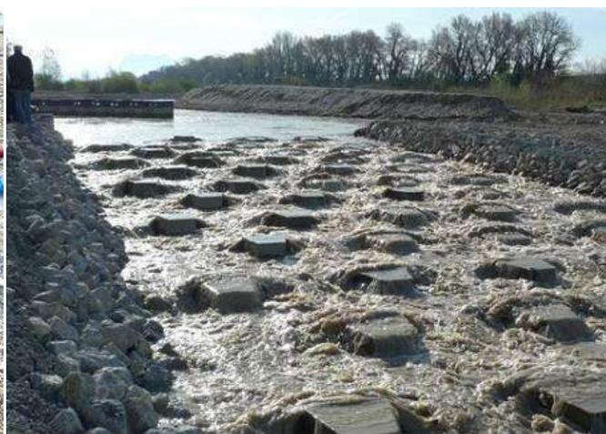
*Figure 28 : Passe à poissons lors de sa mise en service (seuil des Pues sur la Drôme)*
