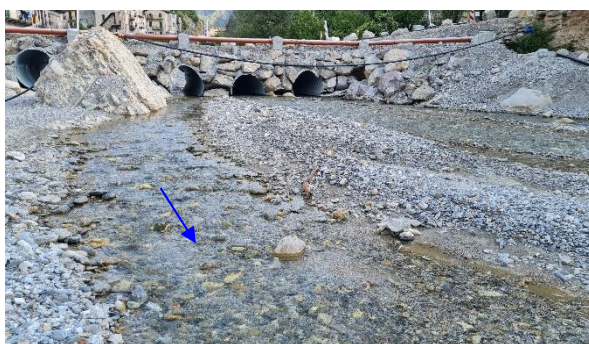
Vue aval du passage busé
