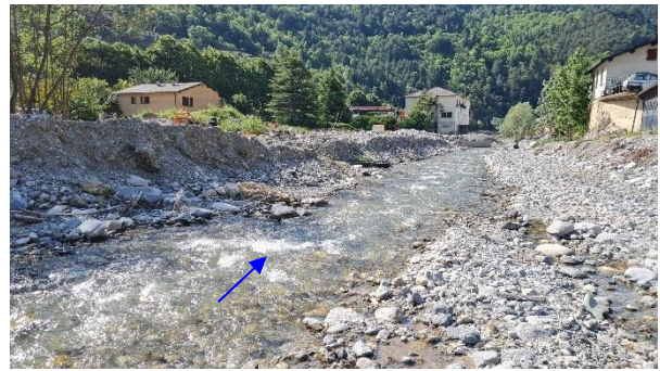
Succession de plat courant / radier sur le secteur en aval du pont voûté
