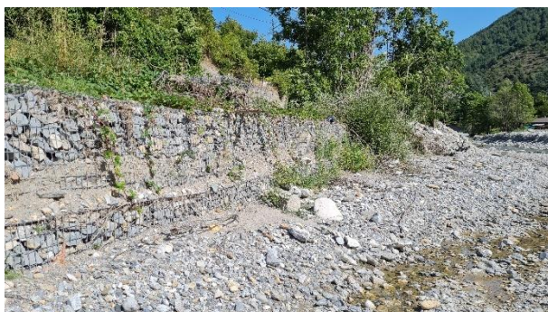
Protection en gabion en rive droite de la Roya en amont du pont provisoire
