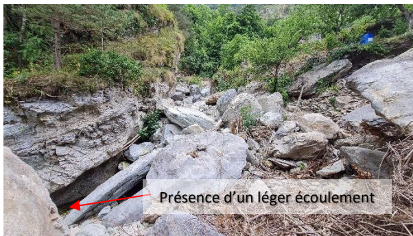
Lit chaotique du Riou en amont des habitations dans Tende
