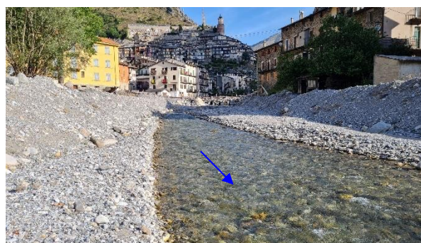
Secteur aval du passage busé
