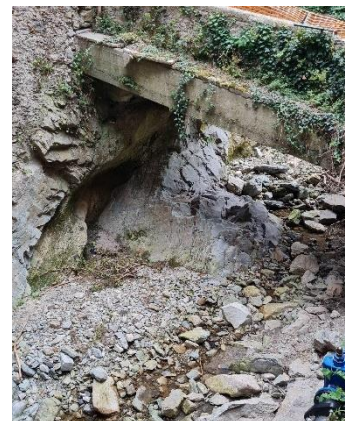
Zone de replat entre deux secteurs à forte pente
