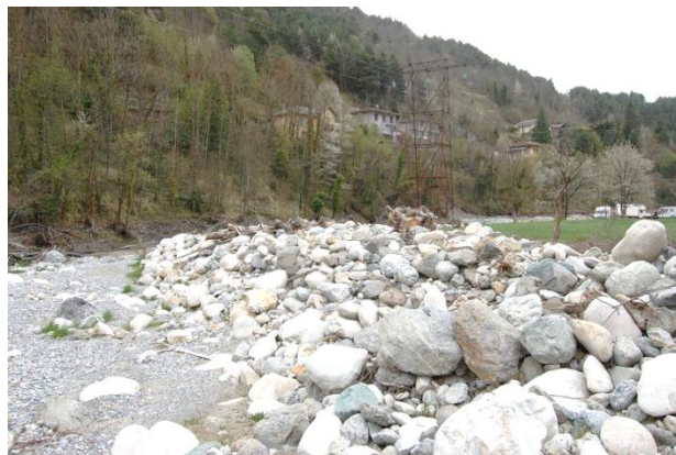
Merlon de blocs rocheux situé sur la rive droite en aval de la zone d'étude
