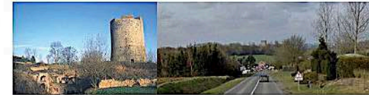
...Et le donjon de Guise depuis ses abords, et depuis la route D946 au sud de Guise (26).
