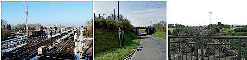
Deux voies ferrées, lignes TER, se rejoignent sur le secteur de projet. Elles desservent la gare de Busigny.
