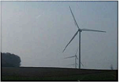
Au droit de la ligne Ouest, composée de quatre éoliennes.
