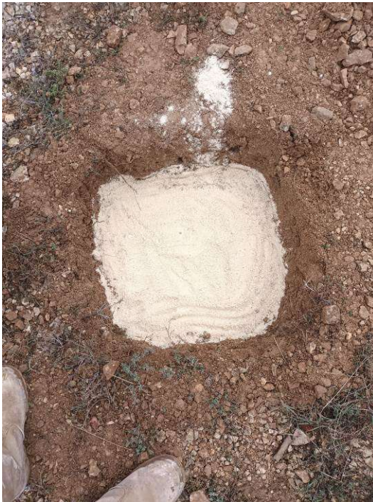
Mise en place d'un gîte élaboré : pose d'un lite de sable et pose du regard béton
