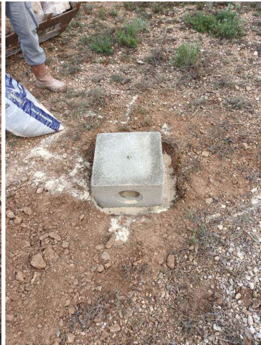
Mise en place d'un gîte élaboré : pose d'un lite de sable et pose du regard béton
