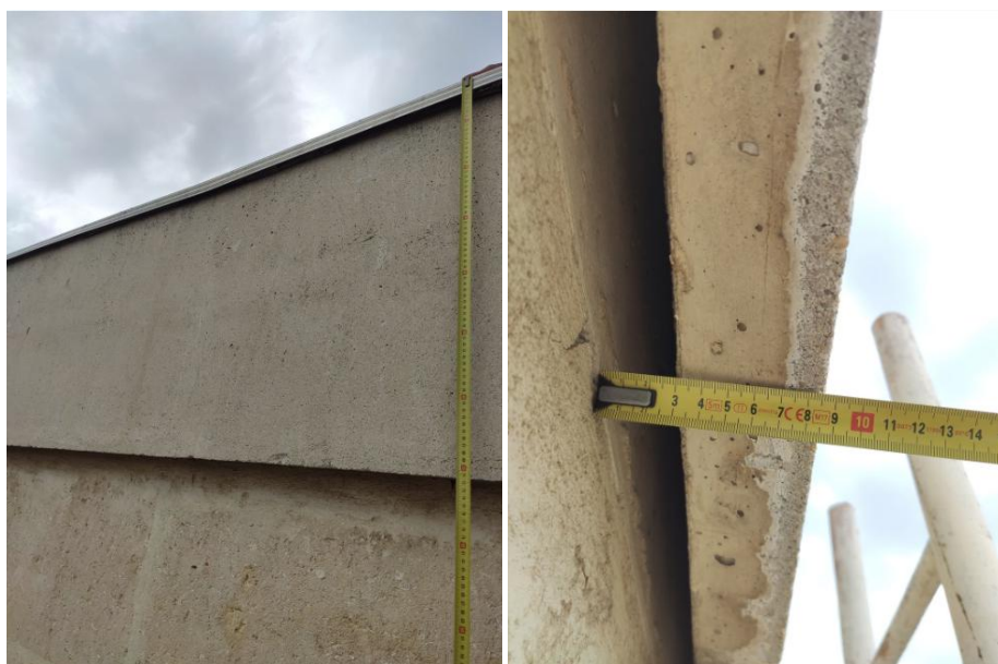
Corniches actuelles de 70cm de haut et avec un interstice favorable aux chiroptères de 3cm de large
