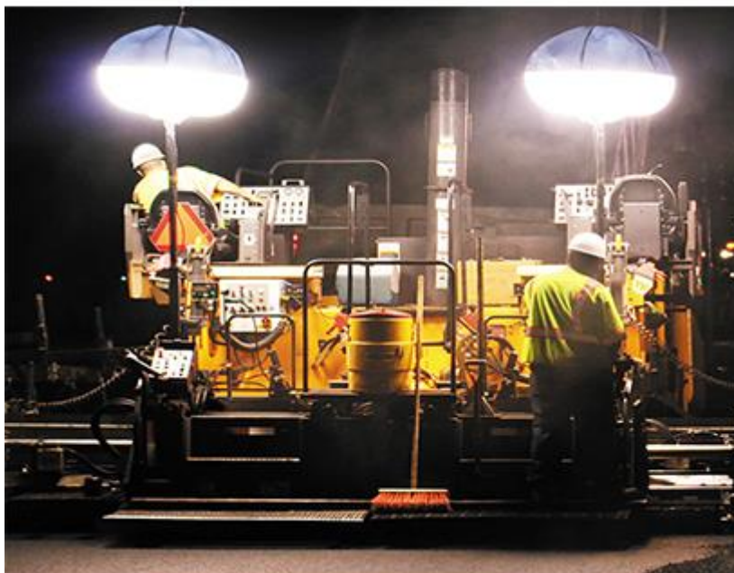
Exemple d'éclairage « globe partiellement occultés » utilisé dans des travaux routiers
