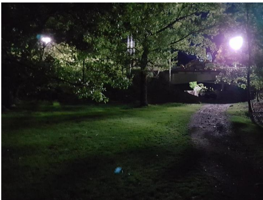
Eclairages du chantier d'enrobé du 15 mai 2018 (photo GCP)
