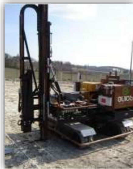
Engin de battage des pieux
