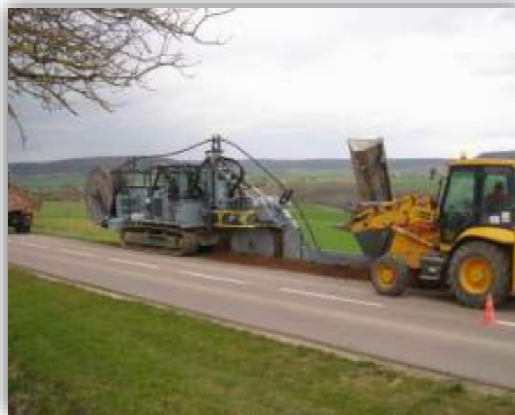
Réalisation de la tranchée
