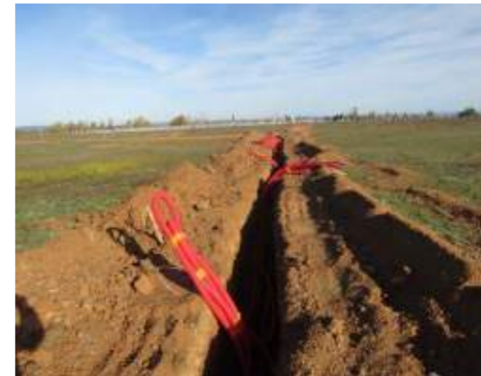
Exemple de tranchée et pose de câbles dans des fourreaux
