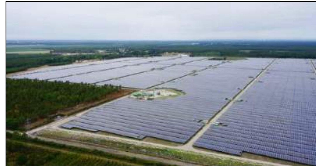
Vue aérienne de la centrale solaire photovoltaïque (300 MWc)
