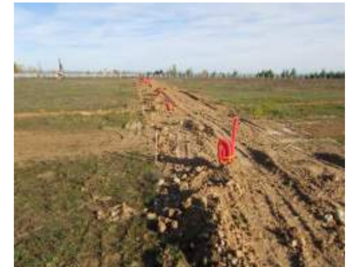
Exemple de tranchée et pose de câbles dans des fourreaux
