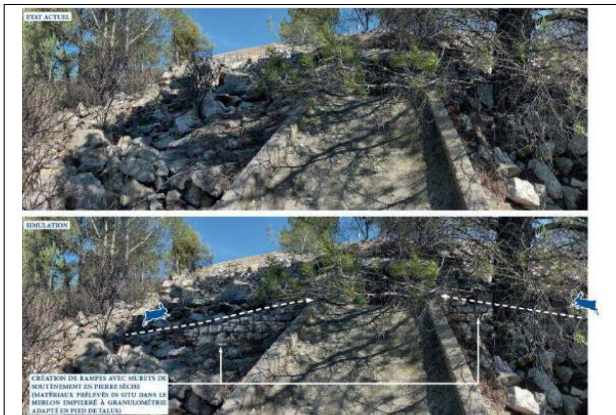
Vue de face de l'ouvrage côté sud (Source : Composite)
