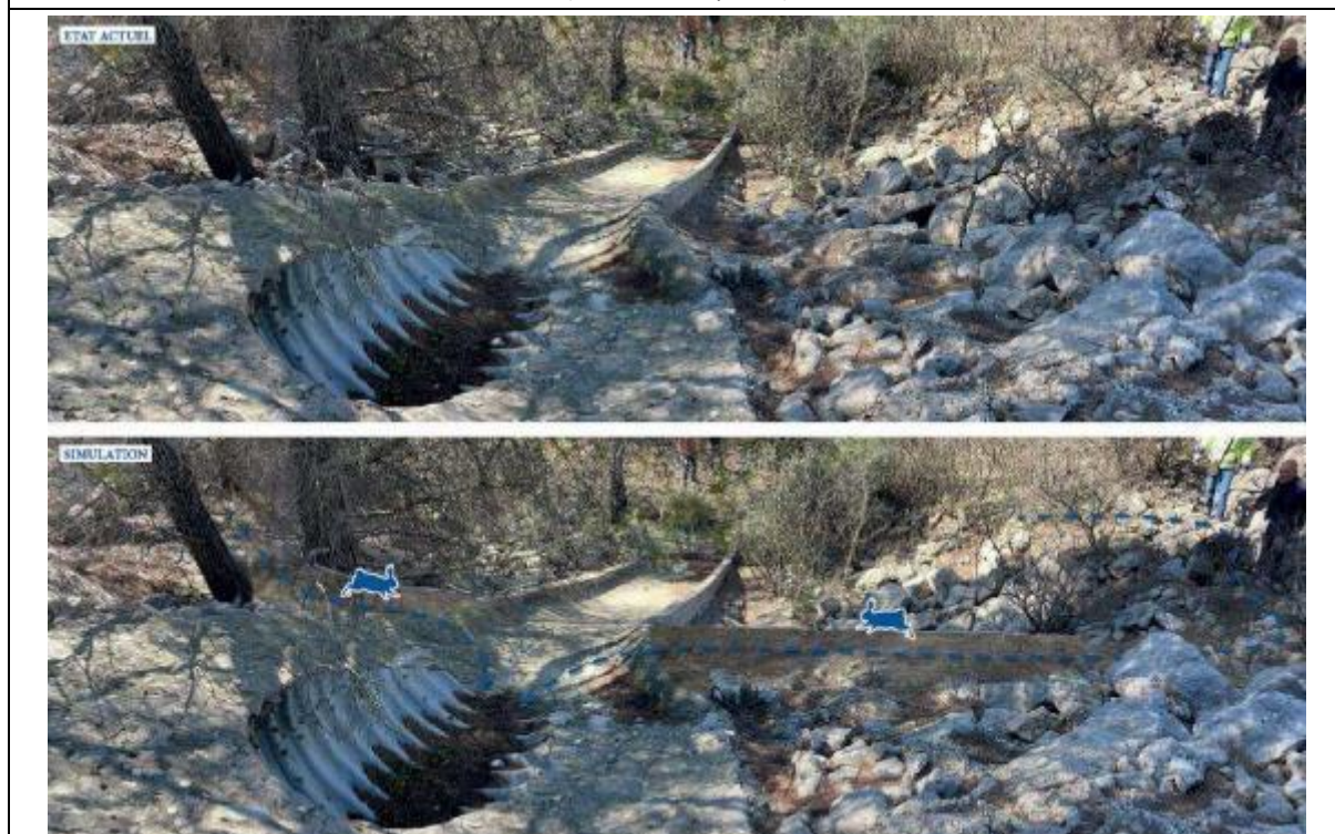
Vue en surplomb de l'ouvrage côté sud (Source : Composite)
