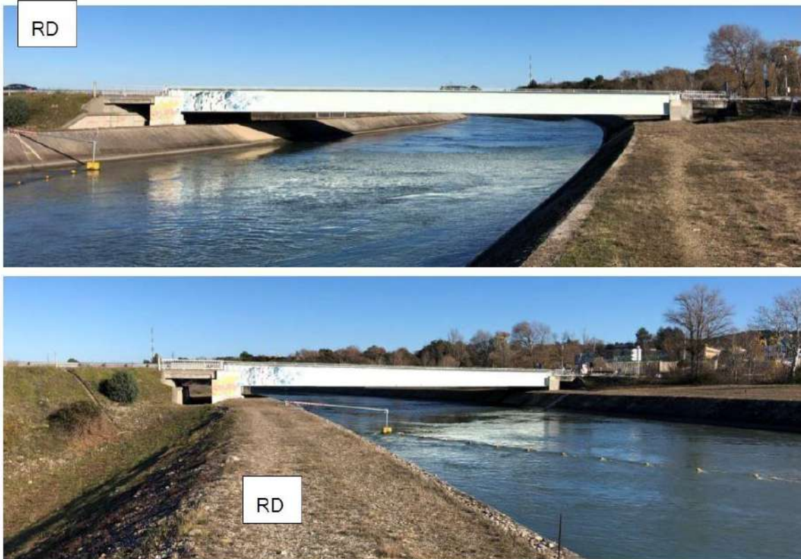
Pont du canal EDF (Source : Escota)
