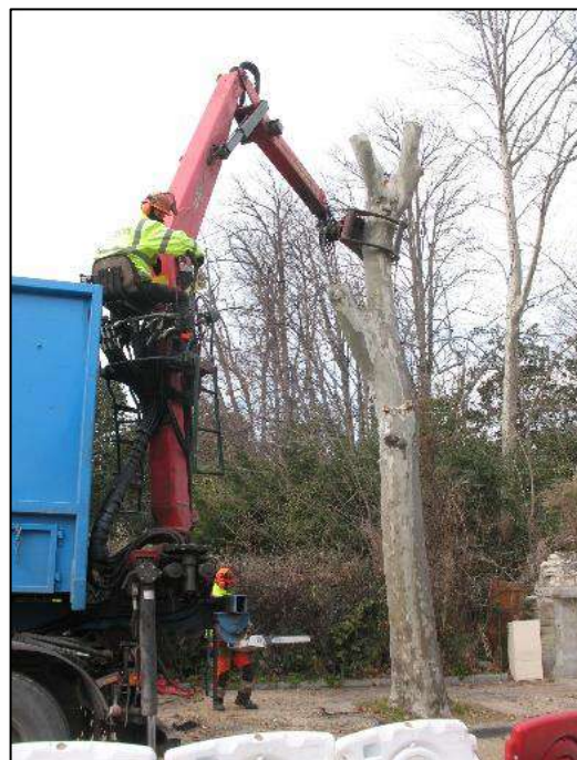
Exemple de dépose délicate d'un tronc creux pouvant abriter des chiroptères ECO-MED
