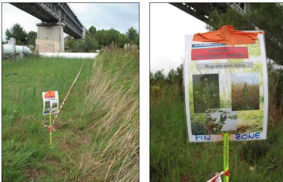
Matérialisation informative des stations d'espèces protégées mises en défens, pour la durée des travaux ECO-MED
