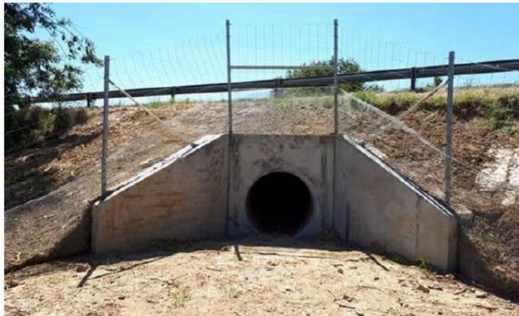
**Exemple d'une entrée d'écoduc en cours de construction (source : EUROVIA)**
