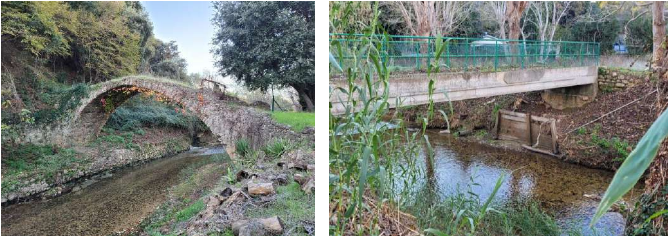
Figure 28 : Ouvrages d'art sur la zone d'étude
