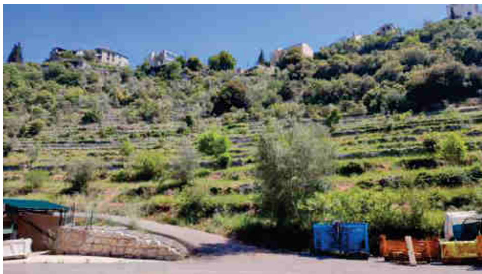
Photo 193. Socle du village de Levens depuis la station d'épuration – Site de compensation 5
