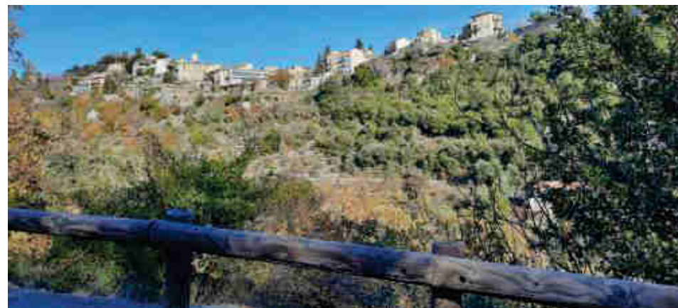
Photo 192. Site de compensation du Socle du village depuis la route de la Molle – Site de compensation 5
