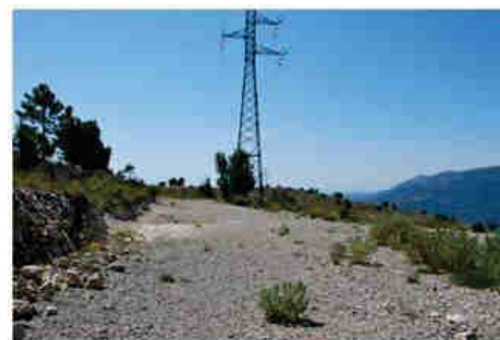
Vue sur la plateforme Est
