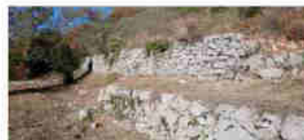
Terrasse en pierres sèches mises à jour après débroussaillage
