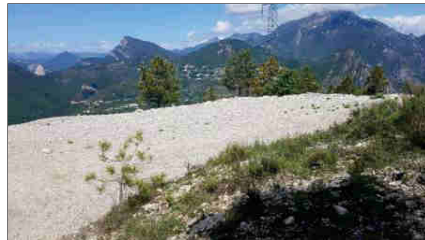
Photo 28. Zone rudérale en dessous des lignes de transport d'électricité - Photo prise sur site
