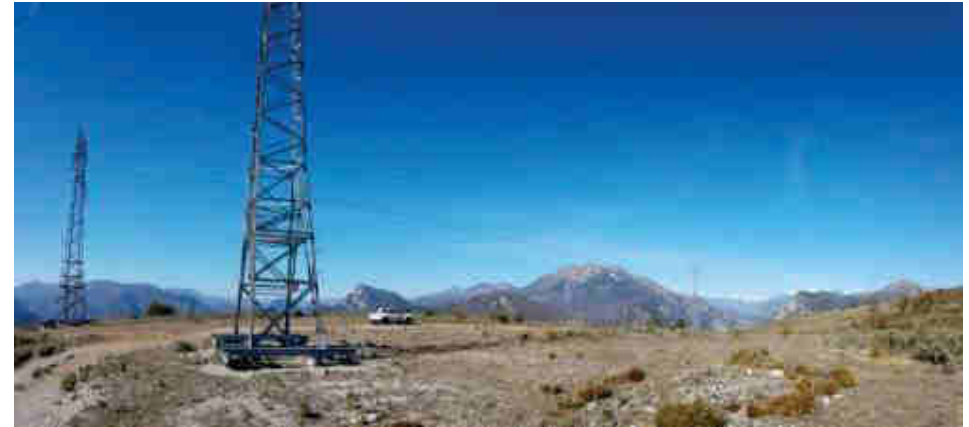
Photo 8. Lignes RTE survolant le secteur d'étude – Photo prise sur site
