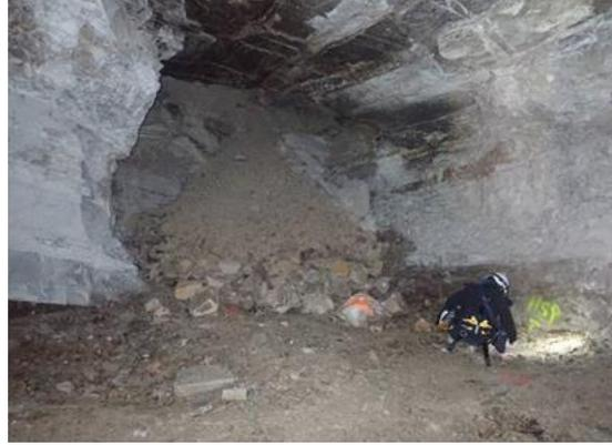
Illustration 24 : Pilier en bon état (photo de gauche), secteur effondré avec écoulement argileux (photo de droite - Marseille (13)).
