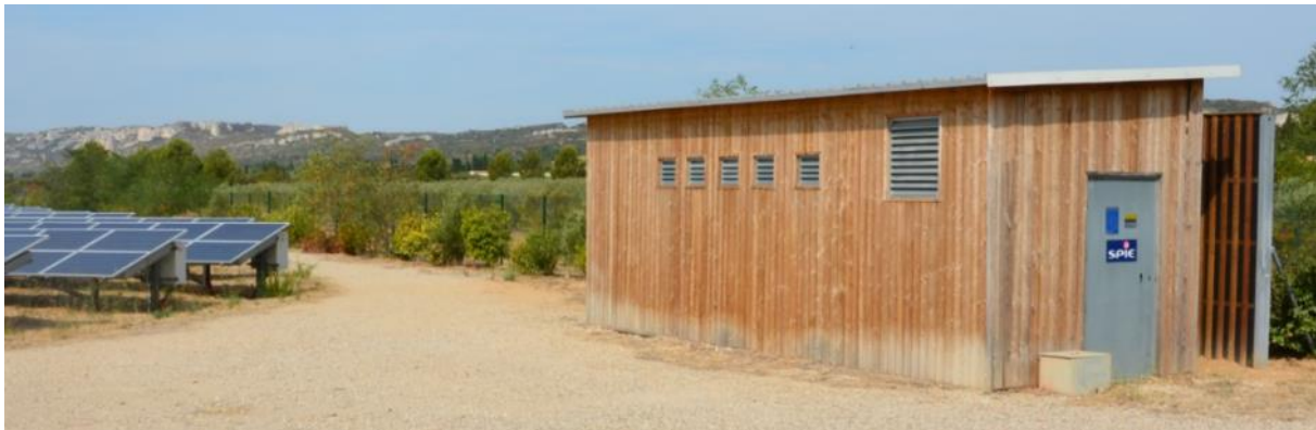
Figure 10 : Photo de local avec bardage bois
