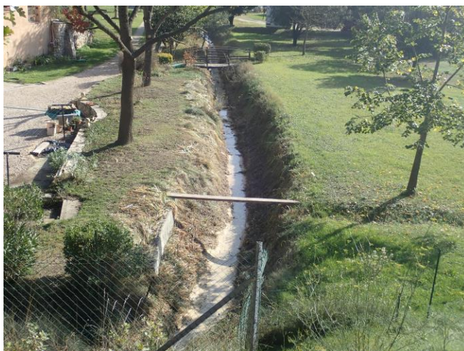
Illustration 20 - Canalisation Madame d'André – canal de surverse du bassin aval - Fuveau (13).
