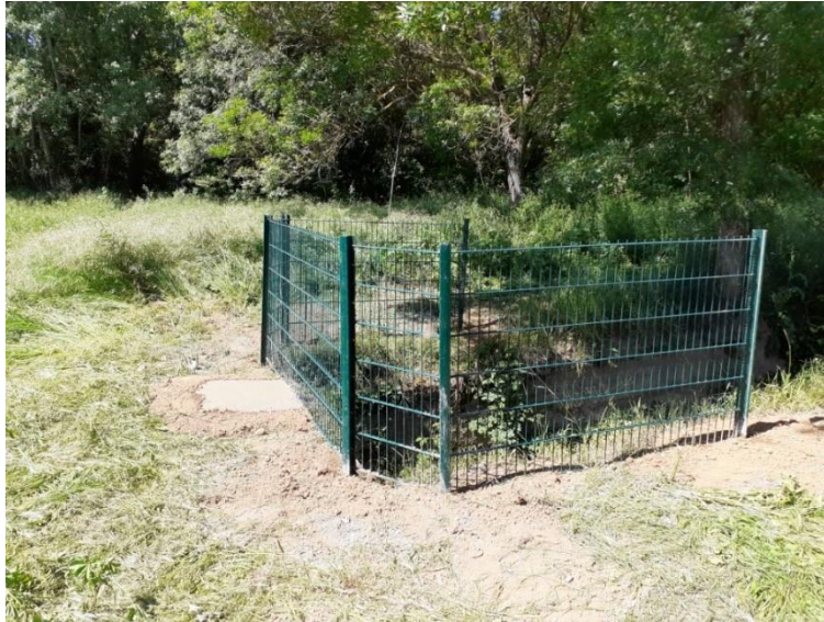
Illustration 7 - Clôture de protection de la galerie Desfarges – Commune de Trets (13).
