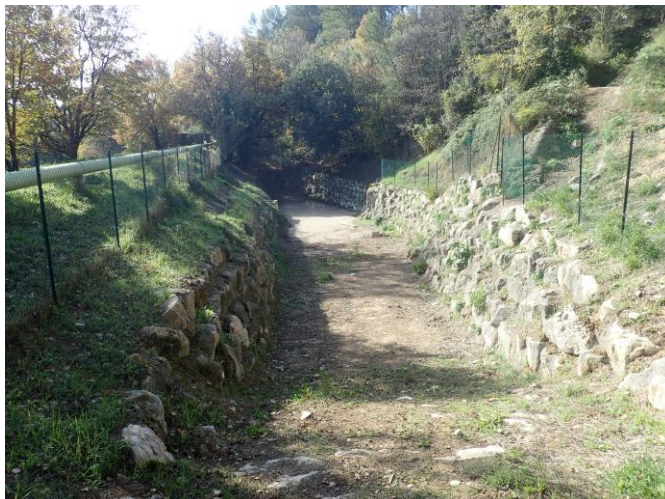
Illustration 19 - Canalisation Madame d'André - vue du bassin aval après débroussaillage et curage - Gréasque (13).
