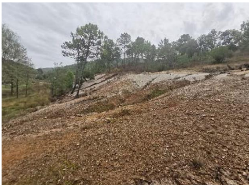
Illustration 36 - Vaucron – Exemple de dépôt de résidus à stabiliser – Vidauban (83).
