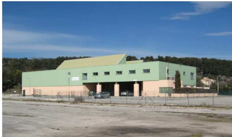
Illustration 2 - Bâtiment de l'UTAM Sud - Commune de Gardanne (13).
