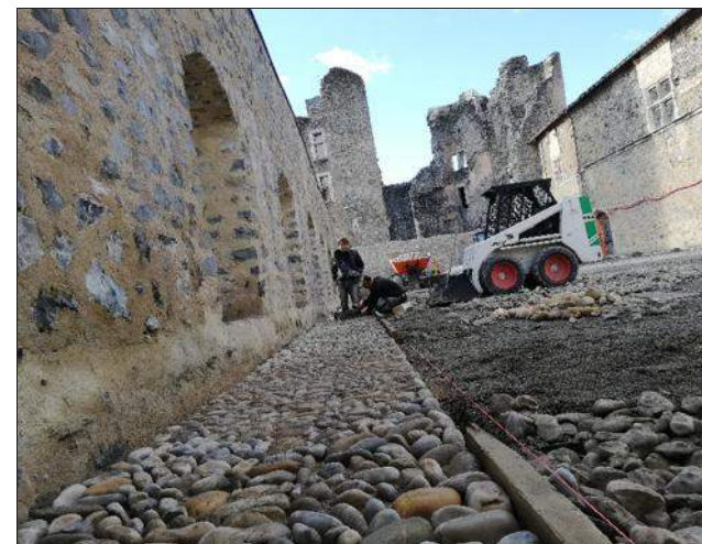
Dans la cour d'honneur du château, des employés communaux déposent la calade (empierrement fait de galets, servant à la décoration) au pied des courtines (murs rectilignes qui joignent les deux tours d'un château).
