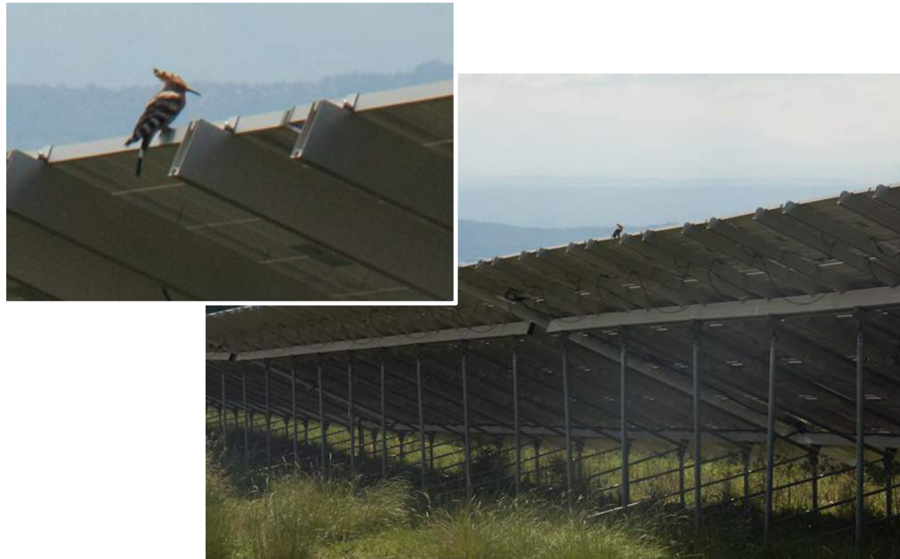
Huppe fasciée ( Upupa epops ) posée sur les panneaux photovoltaïque du parc de Fontienne (04)
