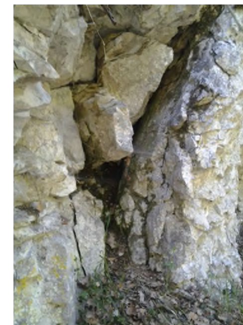
Fissure potentielle (© M. DROUSIE)
