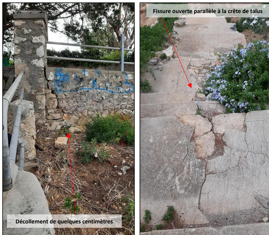
Figure 28 : Photo de l'escalier d'accès à la plage sous la propriété AW-259
