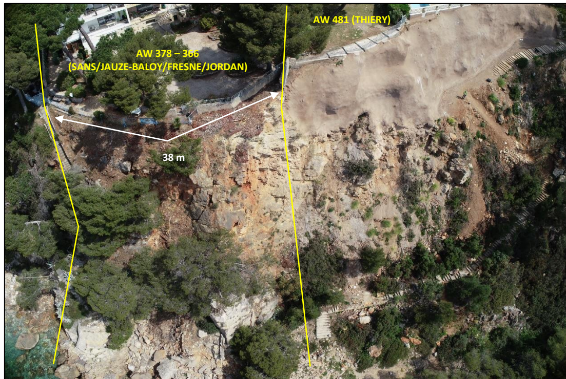
Figure 4 : Vue panoramique de la falaise côté Ouest
