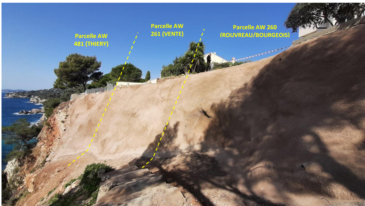
Figure 12 : Photo de la paroi clouée au droit des parcelles AW 481 – 261 – 260
