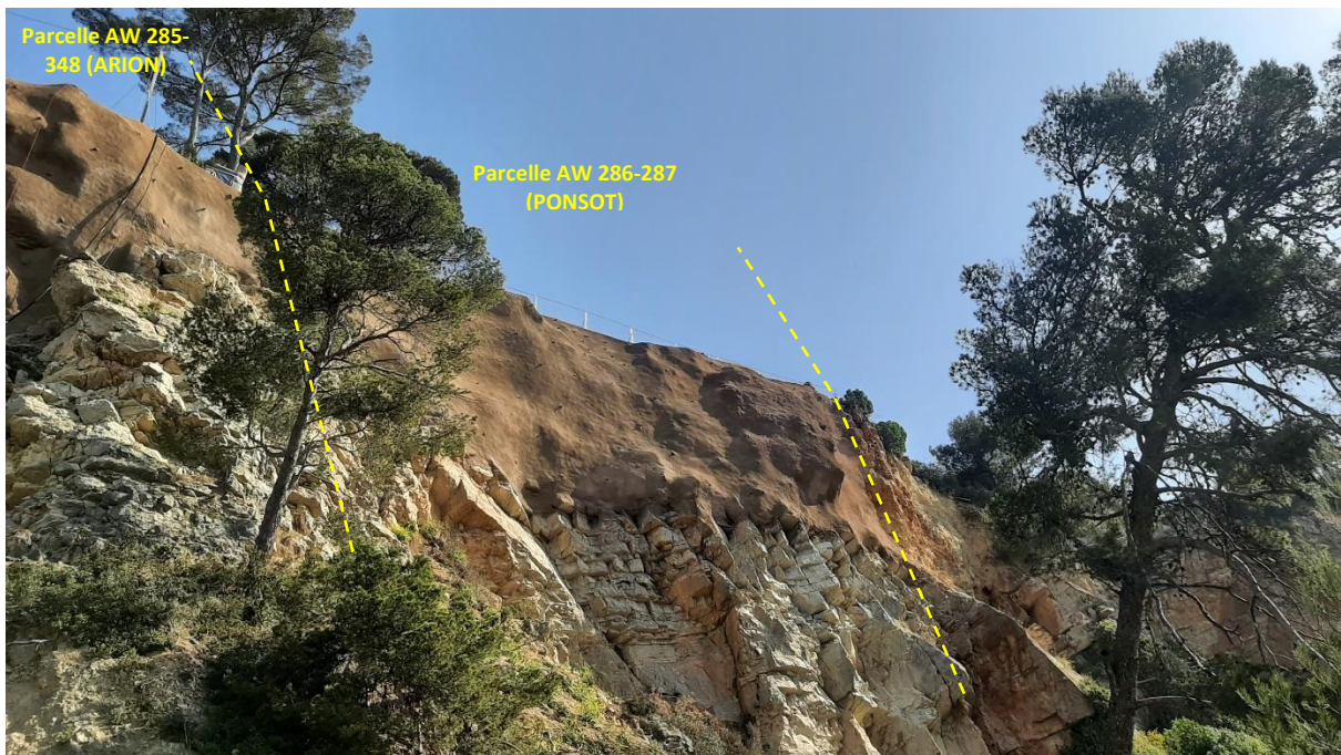
Figure 11 : Photo de la paroi clouée au droit des parcelles AW 285-348 et 286-287
