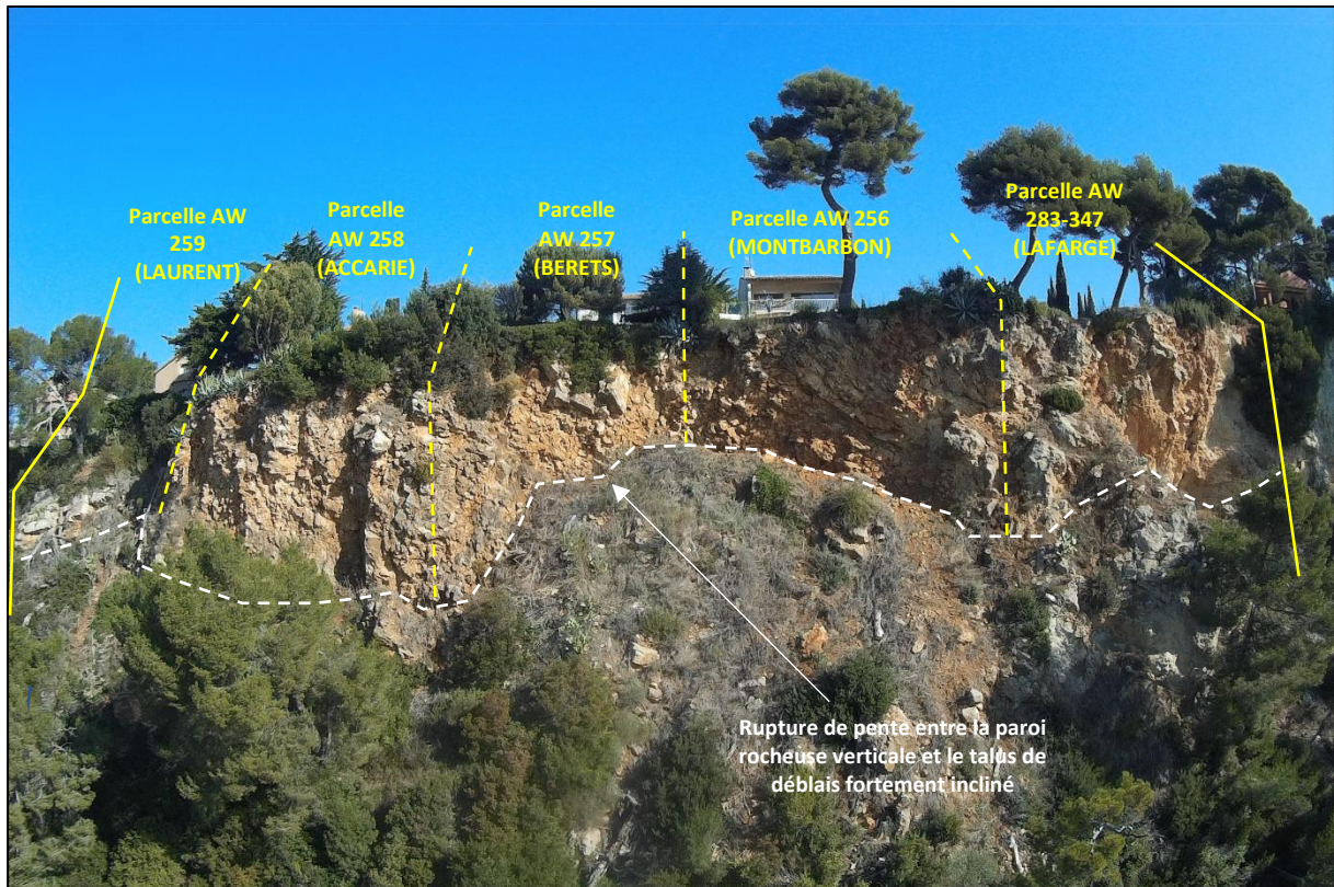
Figure 5 : Vue panoramique de la falaise côté Est
