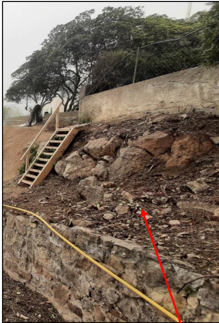
Blocs rocheux fracturé – Terrain en place
