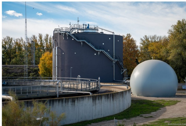
Unité de méthanisation sur la station d'épuration de la Courtine – Avignon
