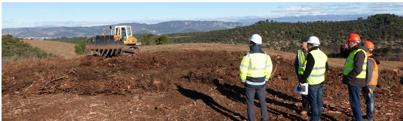
Réunion de chantier avec l'équipe DRYOPTERIS en animation sur les enjeux naturalistes – Suivi DRYOPTERIS dans les Alpes de Haute-Provence (SOLAIREDIRECT)
