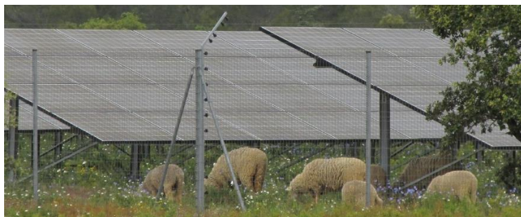
Exemple de pâturage ovin actuellement mis en place au cœur d'un parc photovoltaïque
