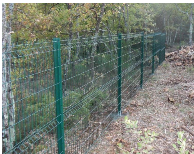
Exemple de clôture– Parc solaire de Montmayon - Source : VOLTALIA -
