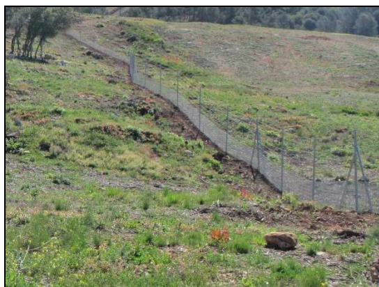
Exemple de clôture amphibiens créée grâce à un filet à petite maille M. JARDE, 28/04/2016, Tourves 83
