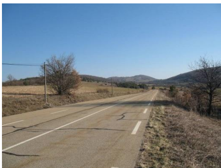
Figure 14 : Vue de la départementale D34 (Source : NEOEN)
