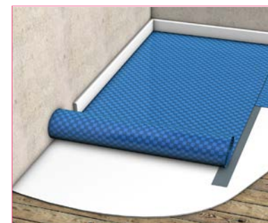
Pose d'un revêtement souple
