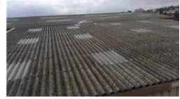
- P041 Toiture n°1 Fibre cimenté
