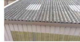
- P043 Toiture n°2 Fibre cimenté
