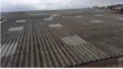
- P044 Toiture n°2 Fibre cimenté
