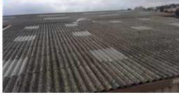
- P042 Toiture n°2 Fibre cimenté
