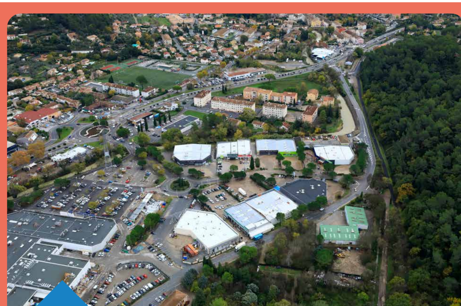
Inondation Trans-en-Provence novembre 2019 (Source © Camille Mairenc, photographe)
