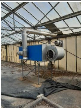
Photographie 3 : Système de chaufferie de la serre
